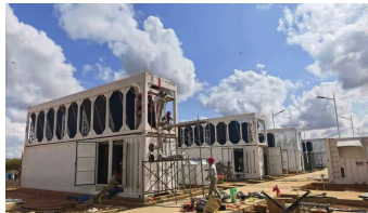
干冷机组模块现场安装
